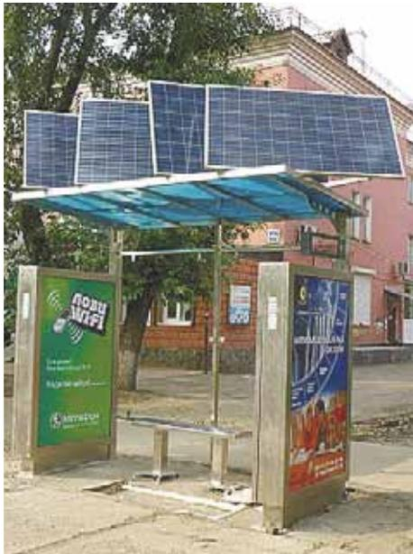
**2. Любопытный проект** реализовали в Иркутске. Там появилась высокотехнологичная остановка общественного транспорта. Уникальная интерактивная конструкция изготовлена из нержавеющей стали и ударопрочного стекла и способна выдерживать температуру до  $-40^{\circ}$ . Комплекс оснащен сенсорным дисплеем с навигационной программой «2GIS», камерой видеона-
